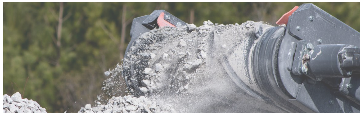
Слика 13. Рециклирање бетона
