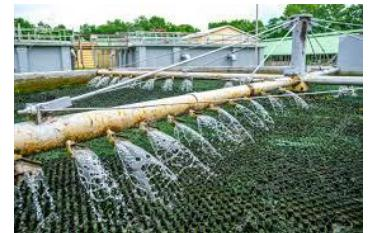
Bio toranj (eng. Bio tower). Otpadne vode često imaju preveliko organsko opterećenje za konvencionalni aerobni tretman. Shodno tome, tretman je neophodan da bi se BPK smanjio na prihvativljiv nivo pre daljeg tretmana. Bio-tornjevi ili filteri za grubu obradu su specijalno dizajnirani kapljični filteri koji rade pri visokom stepenu organskog opterećenja kako bi se postigao visok nivo smanjenja BPK vrednosti.
