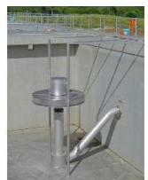
Kapljični filteri. U aerobnim sistemima sa fiksnim filmom biomasa raste kao film na površini i otpadna voda se raspoređuje tako da ravnomerno teče po njoj. Filterski medijum se obično sastoji od kamenja ili raznih vrsta plastike. Tretirana tečnost se sakuplja ispod medija i prenosi u rezervoar za taloženje odakle se deo tečnosti može reciklirati da bi se razblažilo opterećenje zagađivača ulazne otpadne vode.
