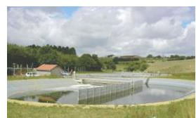
Sistemi sa ubacivanjem čistog kiseonika. Ubrizgavanje čistog kiseonika u postojeće konvencionalno postrojenje za aeraciju.
