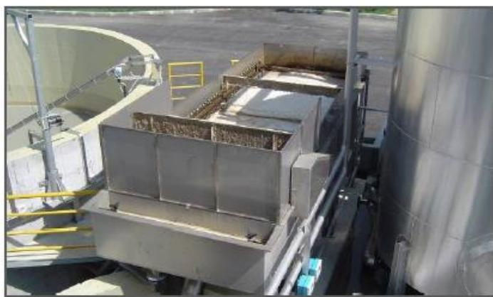
Uljni separator tip UNICELL
