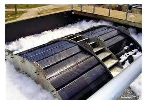
Aerobni filteri visokog i ultra visokog stepena. Biološki tretman otpadnih voda gde se vazduh uvodi kroz mlaznicu, obezbeđujući veliku силу smicanja na bakterije i intenzivan stepen turbulencije/doziranja kiseonika.
