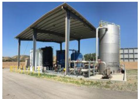
Reaktori sa ekspandiranim granulisanim slojem mulja. U reaktoru se odvija anaerobni proces tretmana gde mikroorganizmi, formiranjem granula, razgrađuju organske zagađivače u odsustvu kiseonika.
